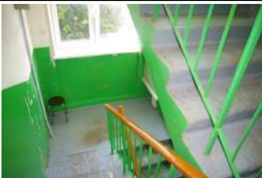
Būve ar kadastra apzīmējumu 1700 033 0077 001, koplietošanas telpa
